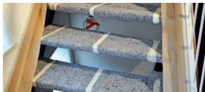
Åbne trapper: Brug kun selvklæbende tape til at fastgøre kanten af afdækningen.
