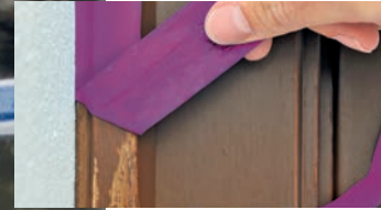
Stripet lak pga. anvendelse af en tape med for stor klæbekraft.
