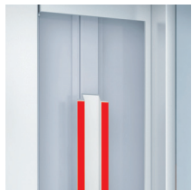
Montaje de barras de refuerzo
